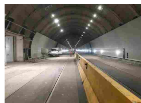
Napoli: Anas, ultimati lavori all'interno Galleria Vittoria
